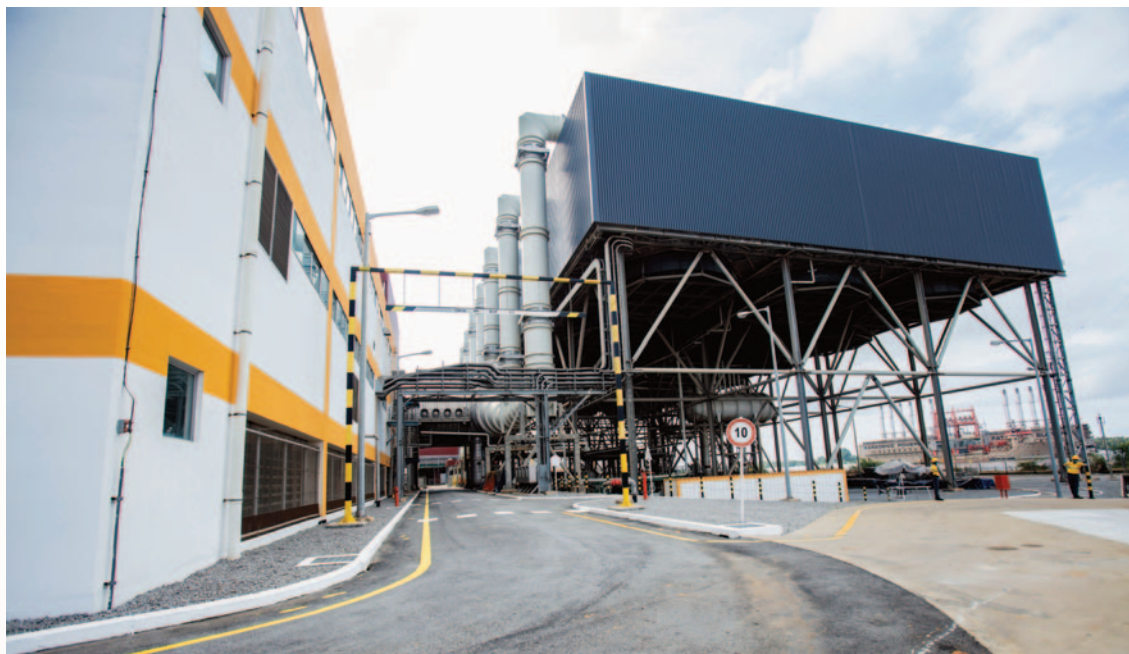
Inauguration de la Phase IV de la centrale thermique d'Azito le 27 Juin 2022 ▲
