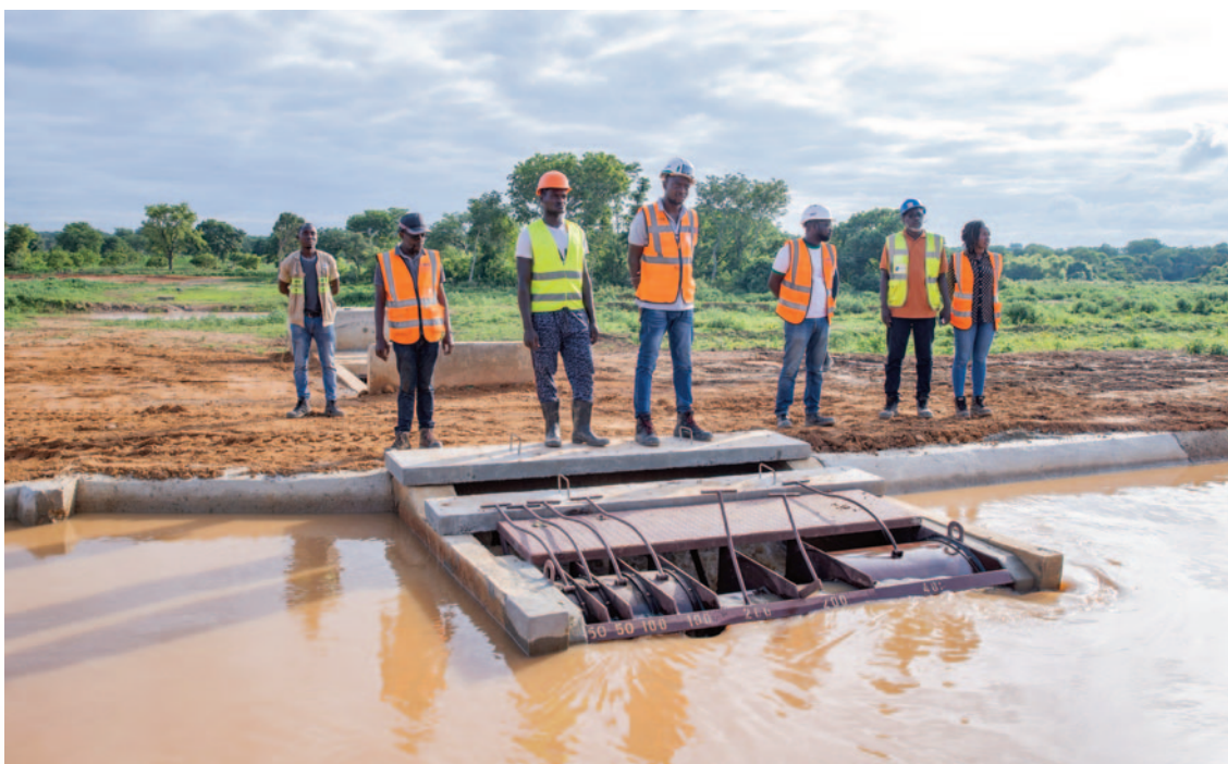
Lancement officiel des travaux du Barrage de Sologo ▲
